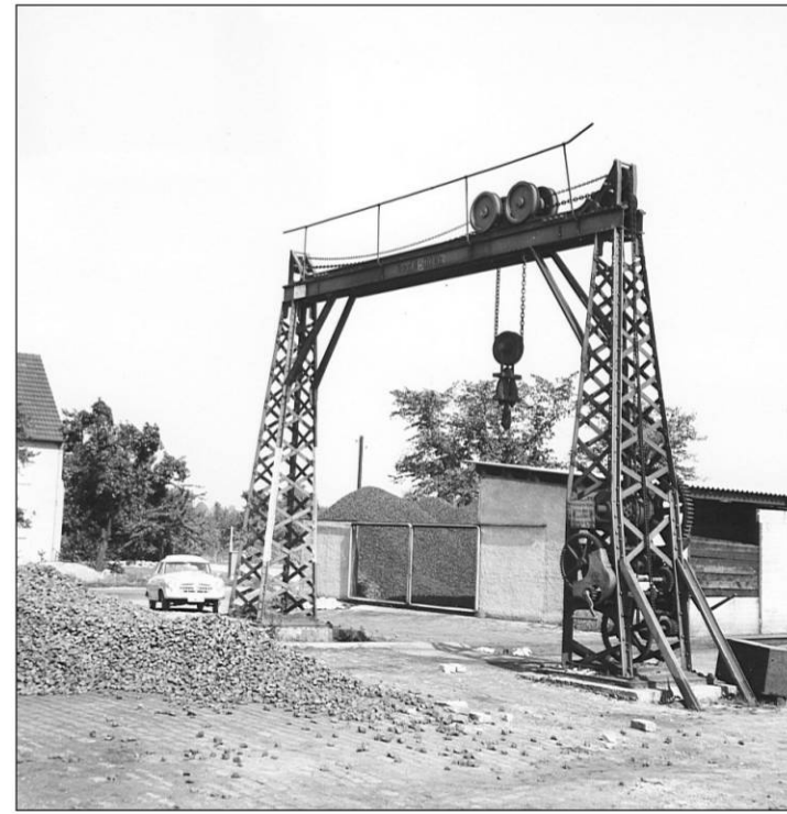
Mühsames Ladegeschäft! Immerhin trägt der damals bereits altmodisch anmutende Bockkran bis zu 4,5 Tonnen. Foto: R. Ertmer, Slg R. Koch
