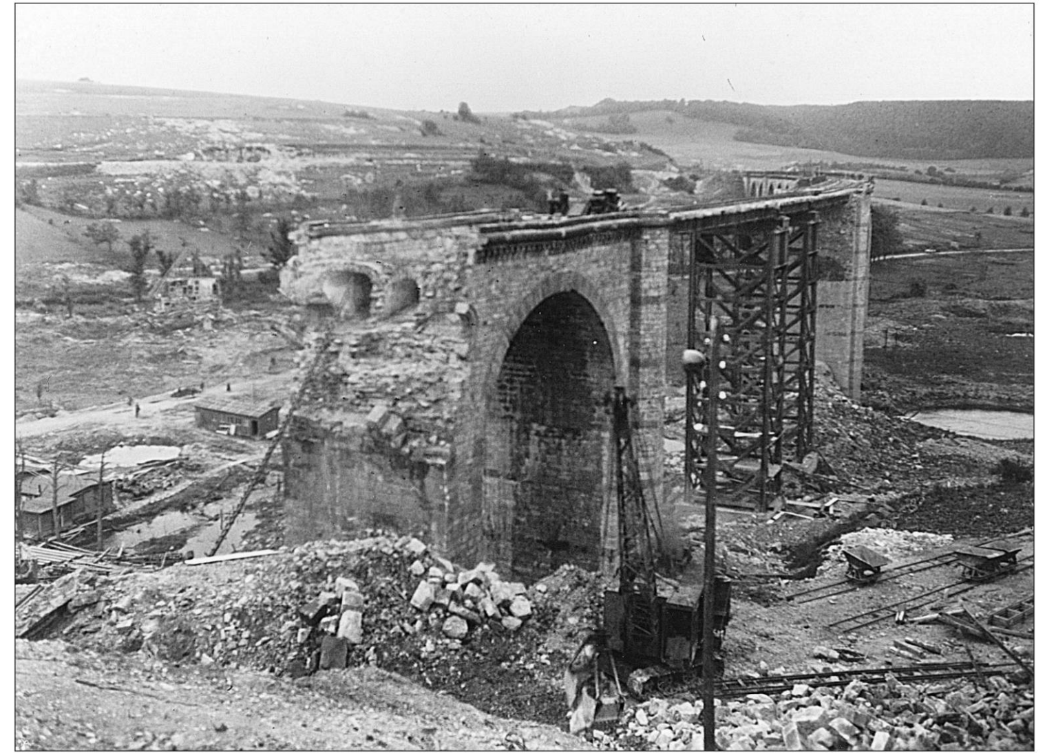
Im Herbst 1945 verlangt die Militärregierung die schnelle Wiederherstellung des Bekeviaduktes für eingleisigen Betrieb. Das Foto zeigt die einsetzenden Bauarbeiten. Bereits am 2. Mai 1946 passieren als erste fahrplanmäßige Züge PZ 1349 ab Paderborn 4.26 Uhr und PZ1350 ab Altenbeken 5.48 Uhr die größte Kalksandsteinbrücke Europas. Foto: Slg R. Koch
